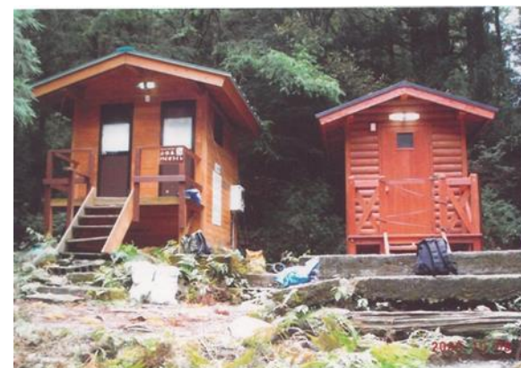
⑪屋久島に設置されたバイオトイレ ↑ 建屋は現地で建設。
