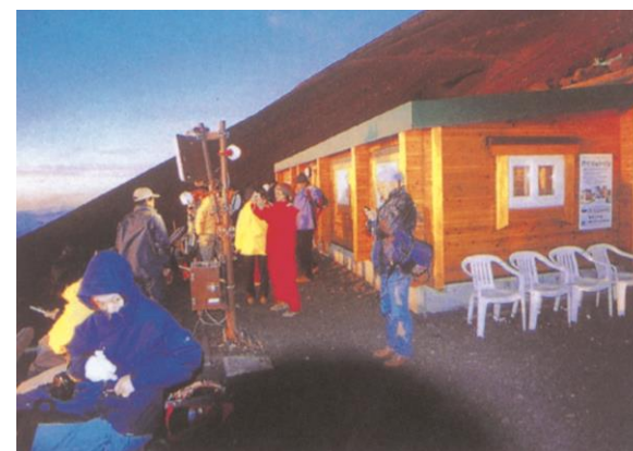
⑫富士山に設置されたバイオトイレ ↓
