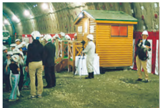
■ 赤岩トンネル工事現場
