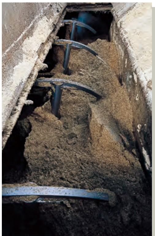
■家畜糞尿投入・攪拌中(上部投入口)
