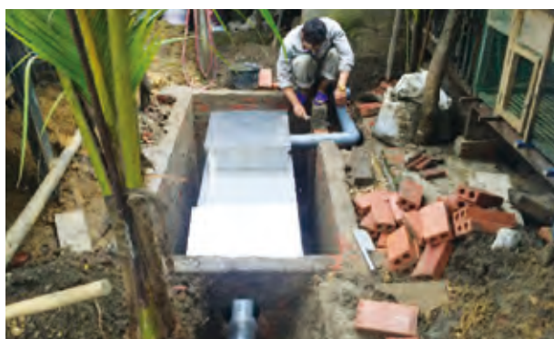
新浄化装置の設置
